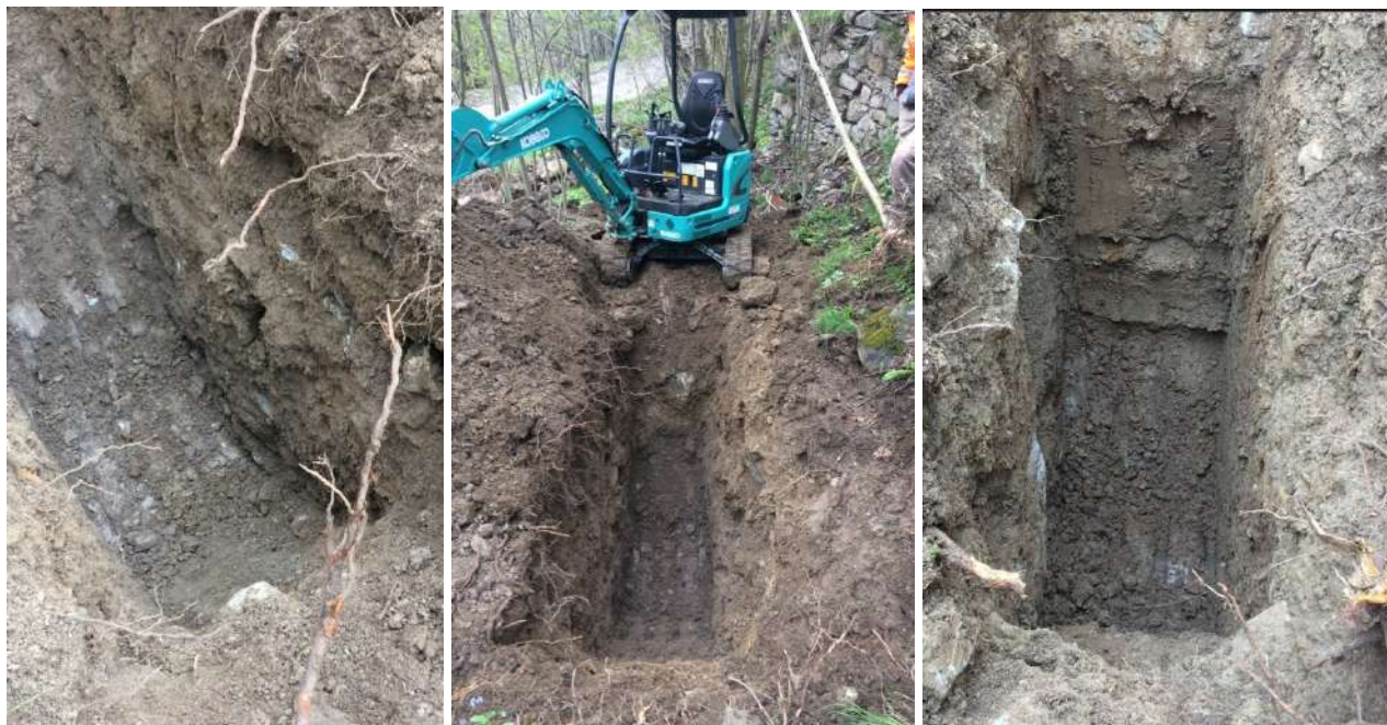
Figura 11 - Da sinistra a destra. Trincea T1, esecuzione della trincea T2 e Trincea T3.
